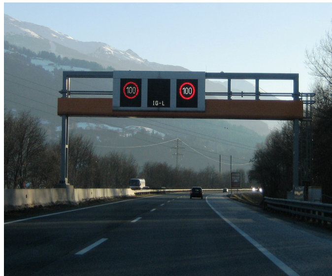
Abbildung 4: Beispiel einer immissionsgesteuerten Tempo 100-Anzeige im Inntal, Tirol. "IG-L": Immissionsschutzgesetz Luft.
